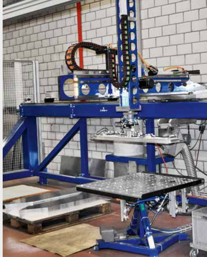
Hohe mechanische Gefährdungen entstehen beim Zuschneiden und Entgraten von Aluminiumplatten.
