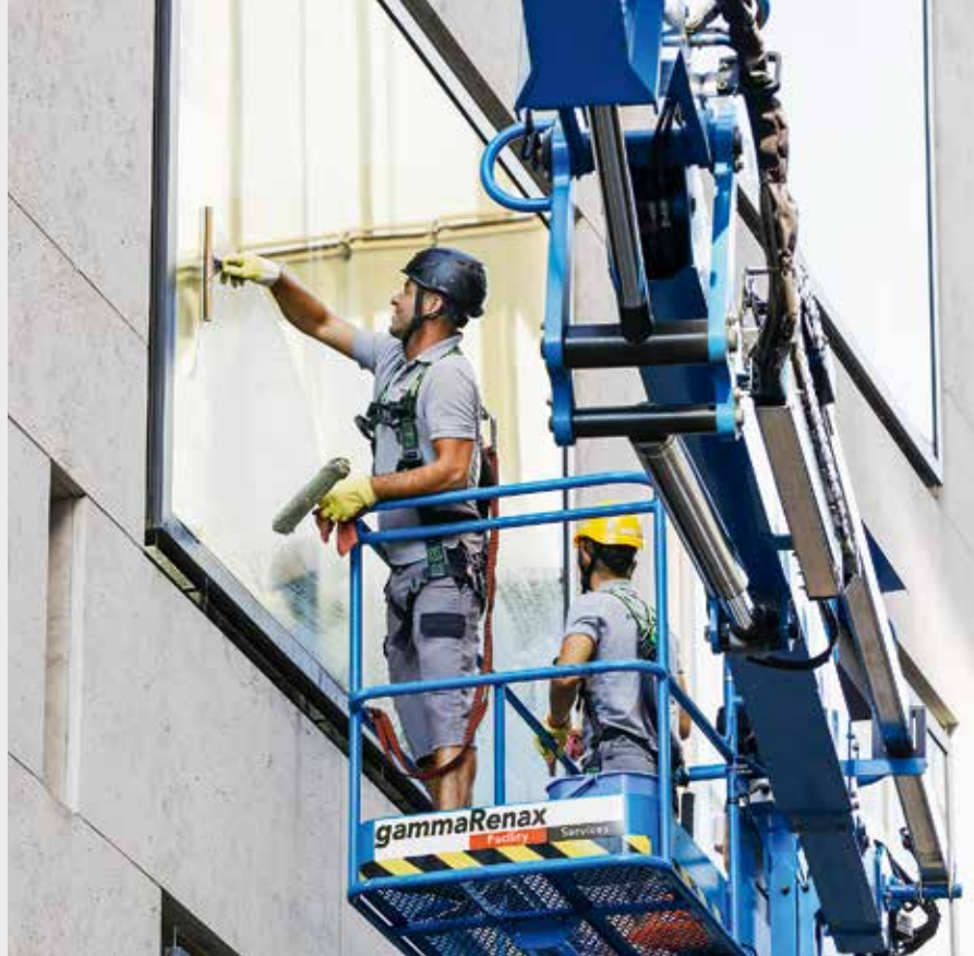
Le nettoyage de façades au moyen de nacelles télescopiques nécessite des mesures de sécurité particulièrement strictes.
