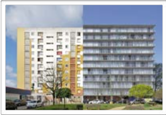
Avant-Après la transformation de 530 logements, quartier du Grand Parc, Bordeaux - Lacaton & Vassal, Druot, Hutin © Philippe Rouault
