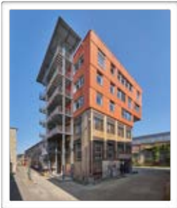
Bâtiment K118 © baubüro in situ ag/Martin Zeller www.studiozeller.com
